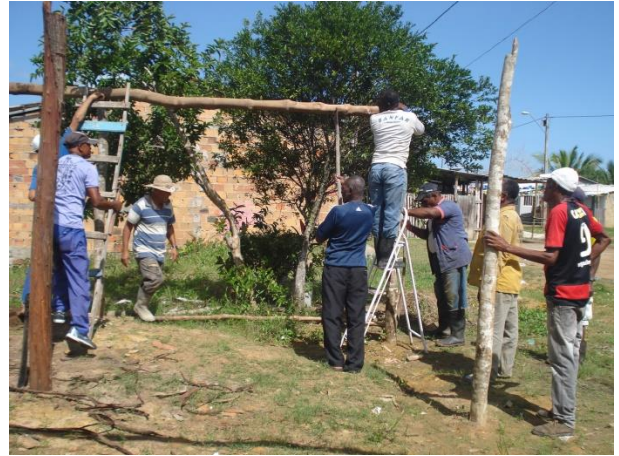
Foto 28- Mutirão 2 construção da cobertura.
